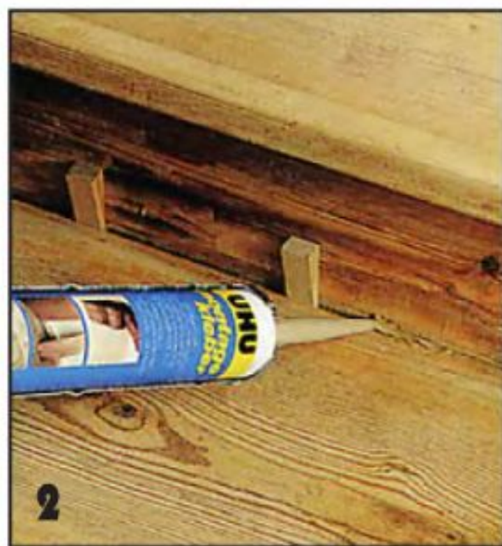
В щель вводят монтажный клей или акриловый герметик. Дают клею высохнуть.
