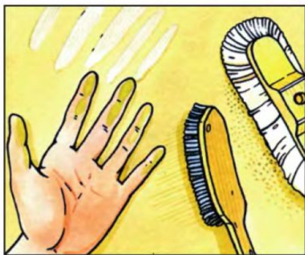
Рис. 6. Осыпающуюся краску следует по меньшей мере основательно зачистить проволочной щёткой с последующим удалением пыли с обработанной поверхности. То же самое касается и нанесённой тонким слоем известковой краски. Подготовленную к окраске поверхность укрепляют грунтовкой.
