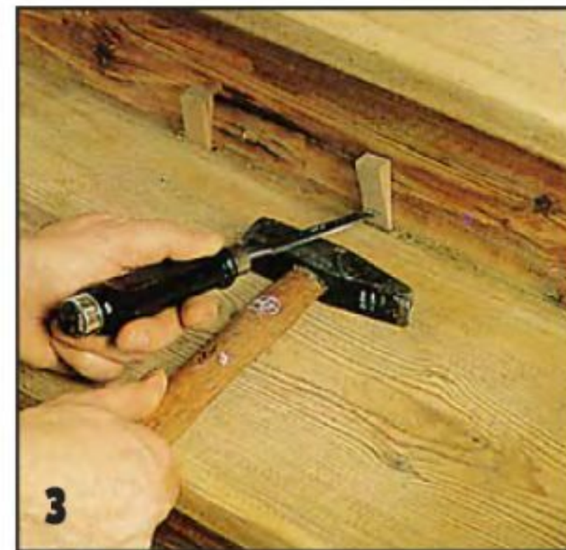
С помощью стамески и молотка, используемого в качестве упора для рычага, клинья извлекают из щели.
