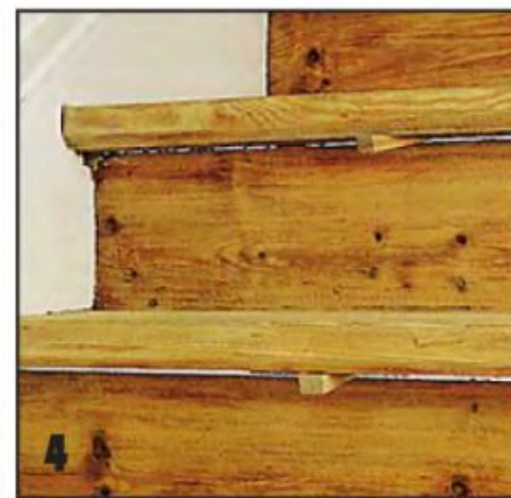
Таким же способом расклинивают стык свеса проступи и верхней кромки подступёнка. Расширенную щель заполняют эластичным акриловым герметиком, придающим ступени пружинящие свойства.
