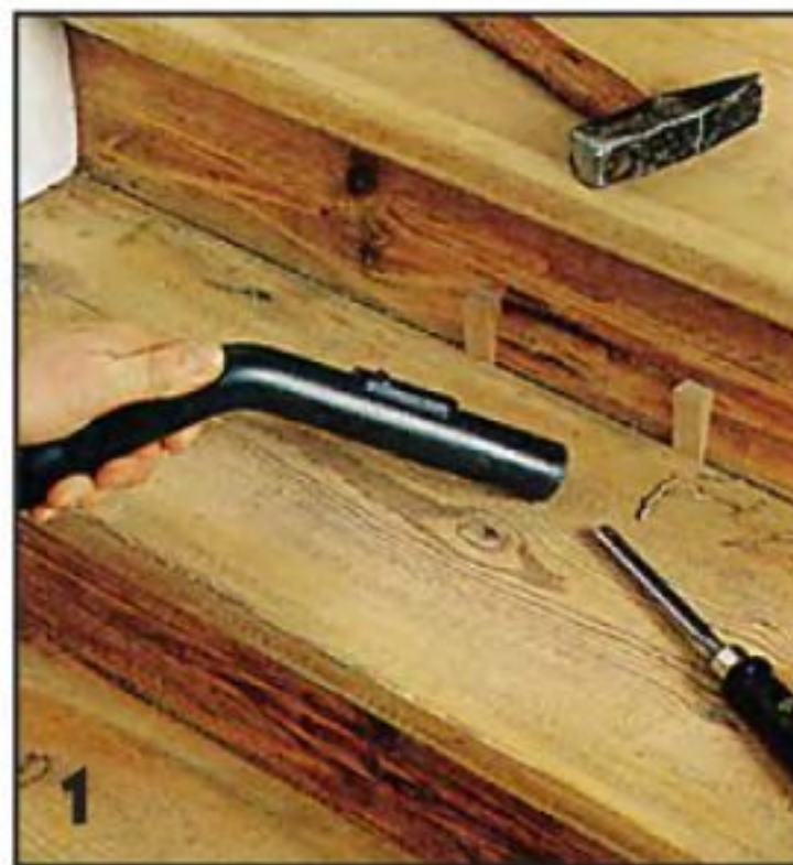
Забив клинья в щель между подступёнком и тыльной кромкой проступи, из неё с помощью стамески, ножа и пылесоса удаляют скопившийся там мусор.
